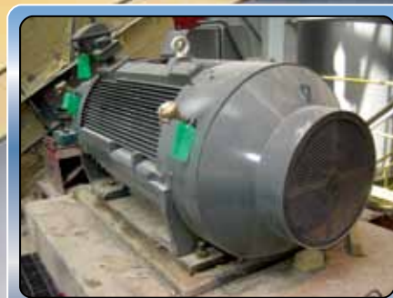
Baghouse ID Fan
